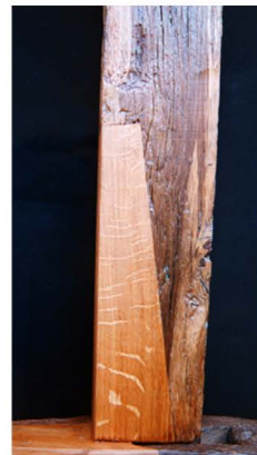
Il tenone illustrato in precedenza a pagina 10 completamente restaurato e ripristinato all'uso.
