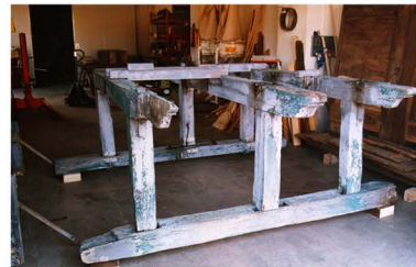
Il telaio supportante le campane rimontato in laboratorio dopo lo smontaggio.
