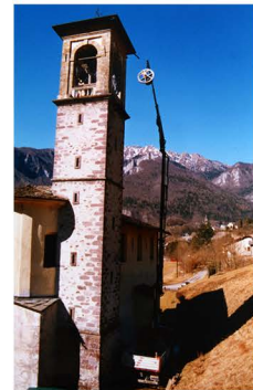
Un'immagine dello smontaggio delle campane effettuato con autogru.
